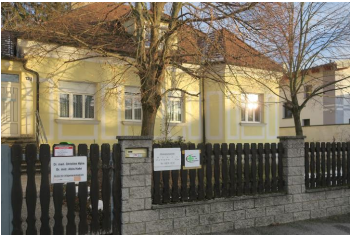
Im Arzthaus werden im Zusammenhang mit der Praxis-Übergabe die erforderlichen Adaptierungsarbeiten vorgenommen
